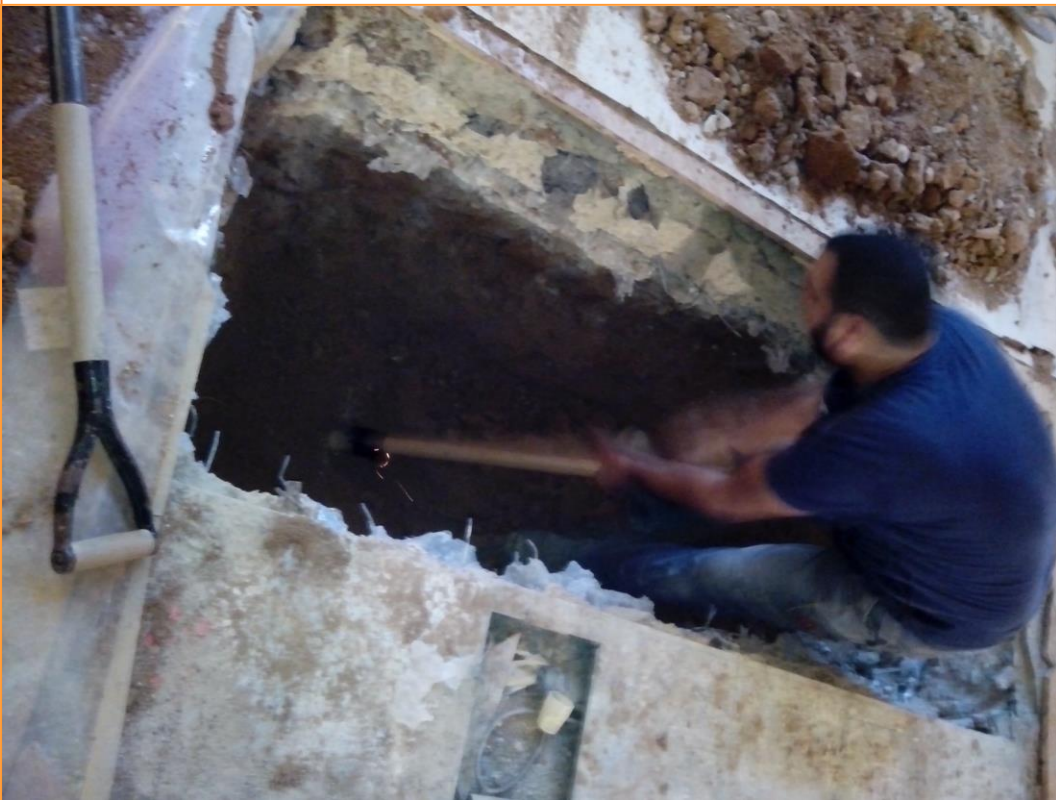
Foto 2. Rebaix del sediment de la cala 1.
