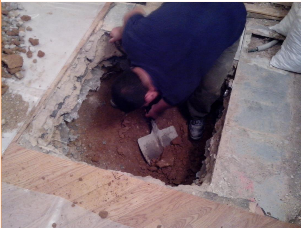
Foto 10. Rebaix del sediment de la cala 2.
