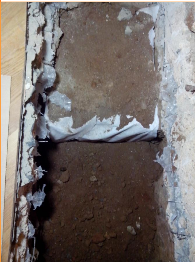
Foto 24. Reompliment amb terra de la cala 1.
