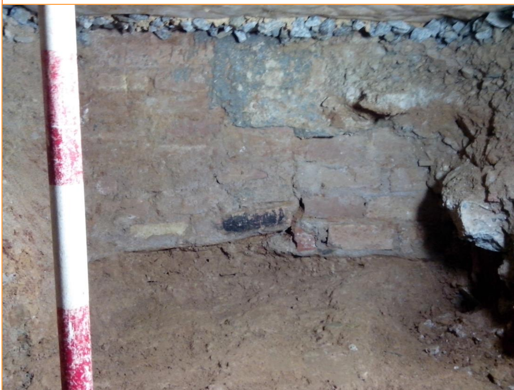
Foto 14. Fonaments (UE 9) del mur de façana amb Passeig de Gràcia, cala 2.
