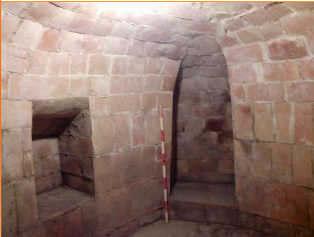
Foto 28. Vista de les obertures de la sala de la fresquera.
