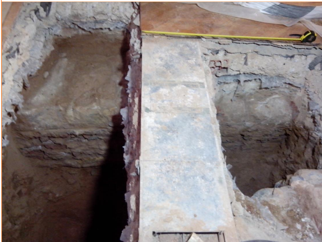
Foto 8. Vista general de l'estructura UE 4.
